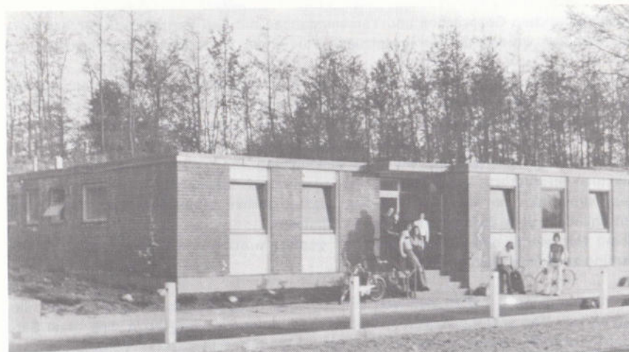
Umkleide- und Sanitärgebäude auf dem „Stoschplatz“
