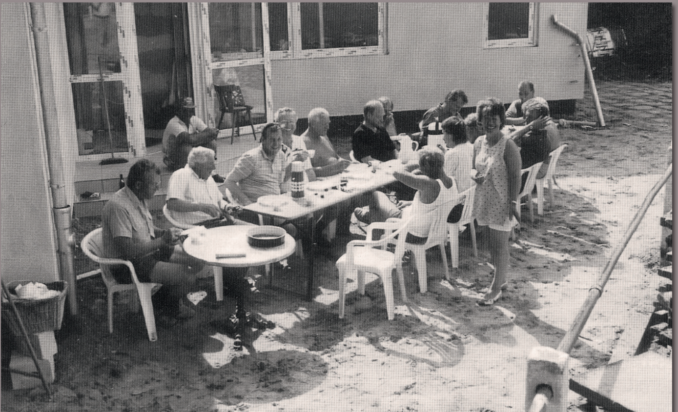
1994, Um- und Erweiterungsbau des Sportheimes in Eigenleistung
